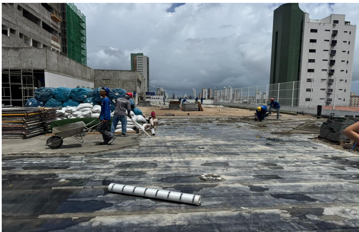
Figura 21. Aplicação de manta asfáltica dupla.
