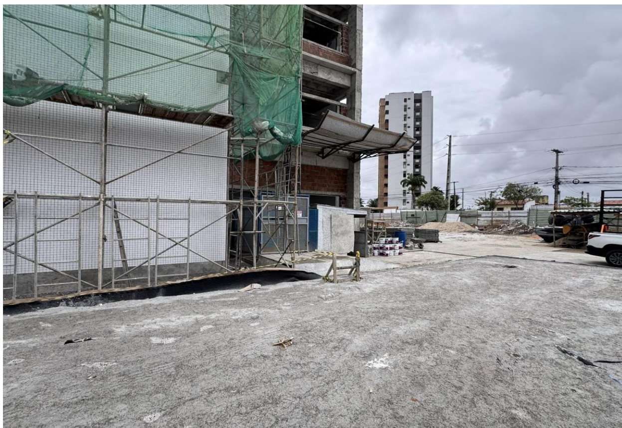
Figura 23. Execução de Manta têxtil drenante, Macdrain.
