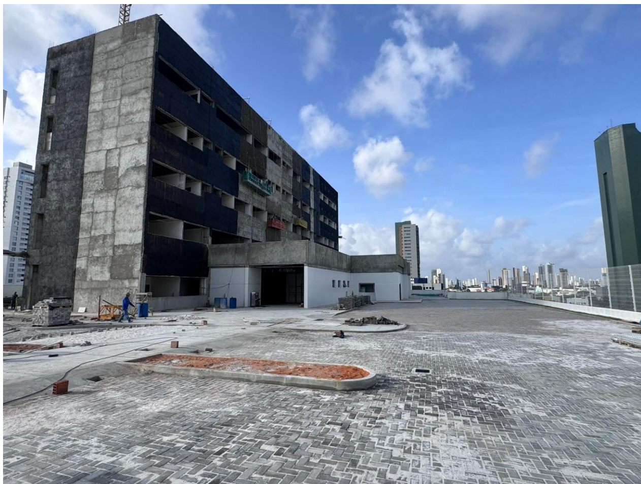
Figura 1. Visão geral da obra.
