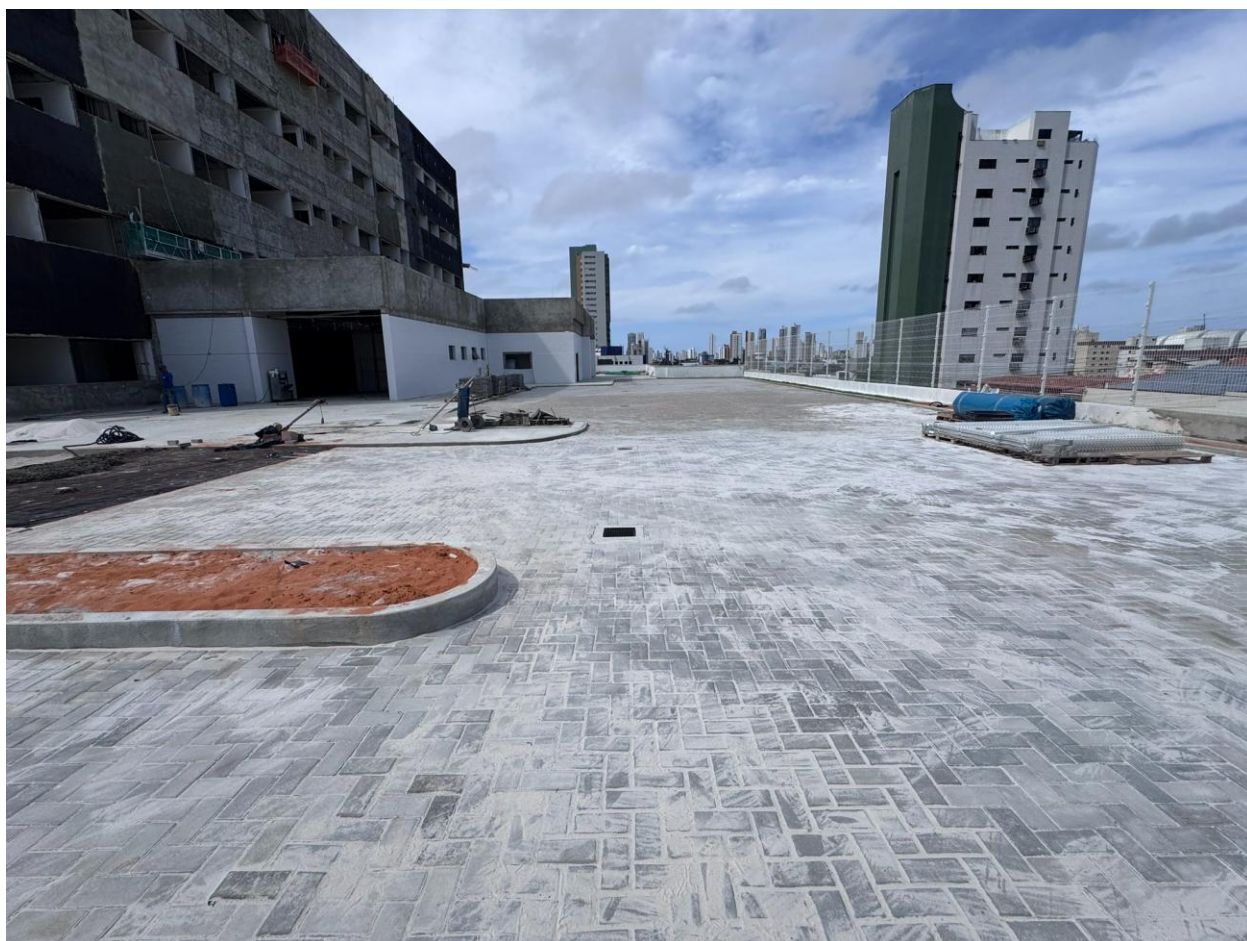
Figura 21. Instalação do piso intertravado..
