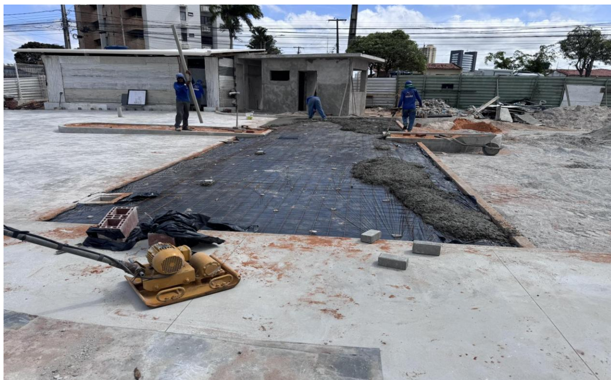
Figura 18. Concretagem da calçada e piso cimentado na entrada do prédio e preparo para aplicação do piso intertravado.
