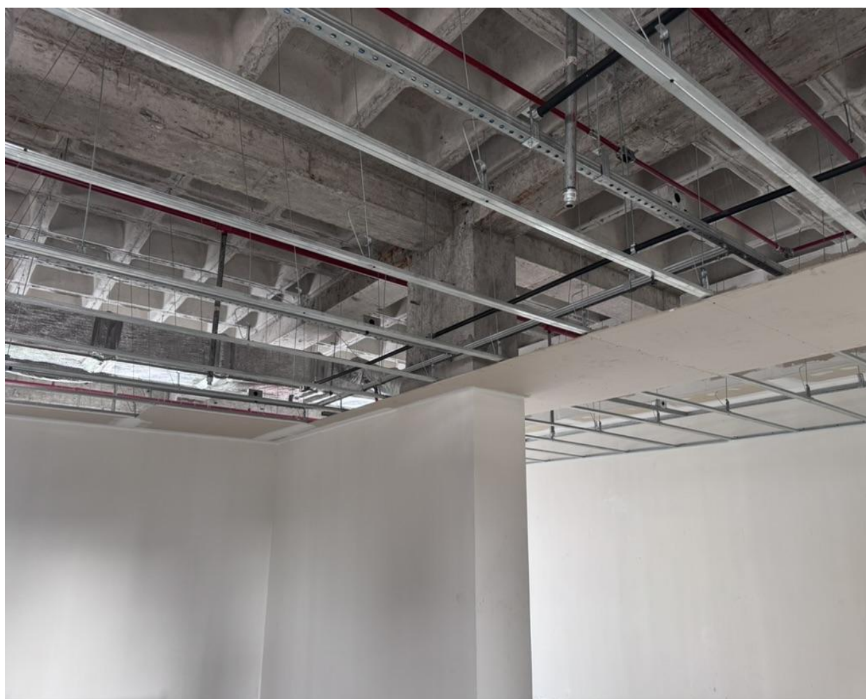
Figura 26. Eletroduto em aço galvanizado e conduletes de alumínio.
