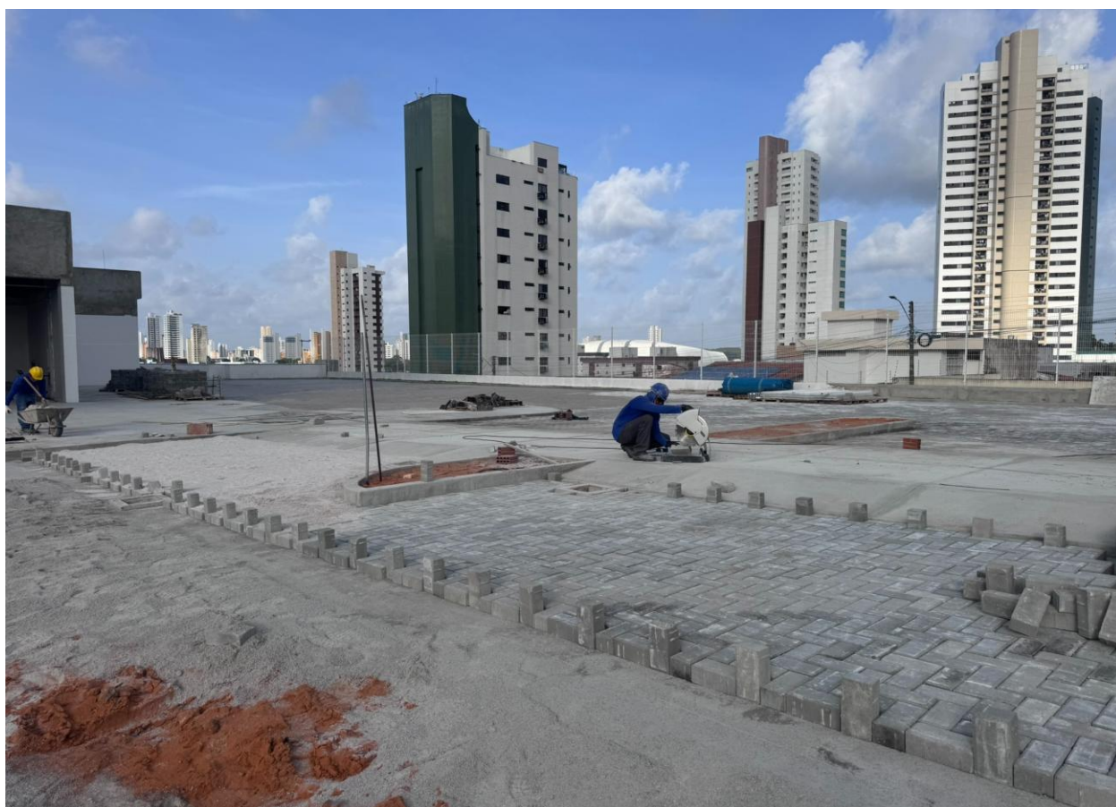
Figura 19. Instalação do piso intertravado.
