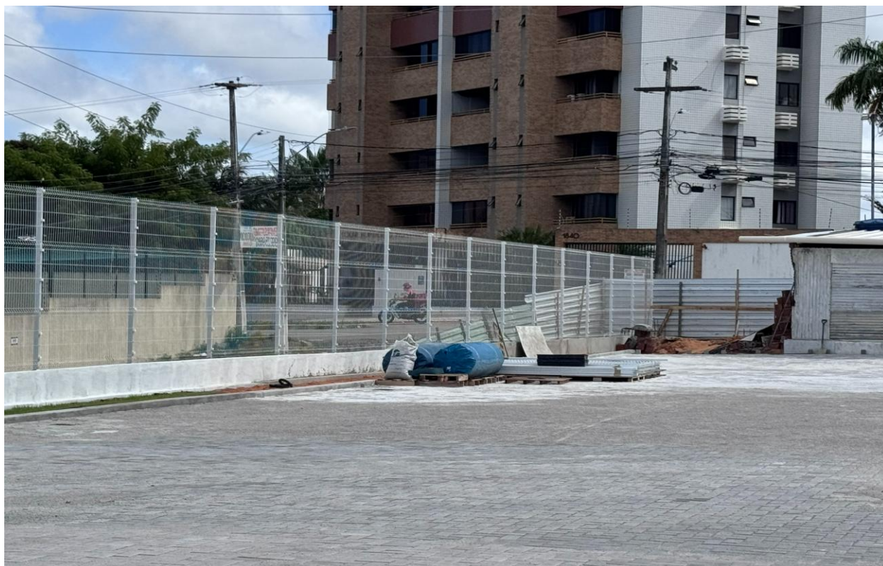
Figura 18. Instalação de gradil e mureta.
