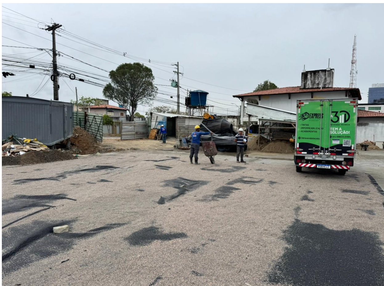
Figura 22. Execução de Manta têxtil drenante, Macdrain.
