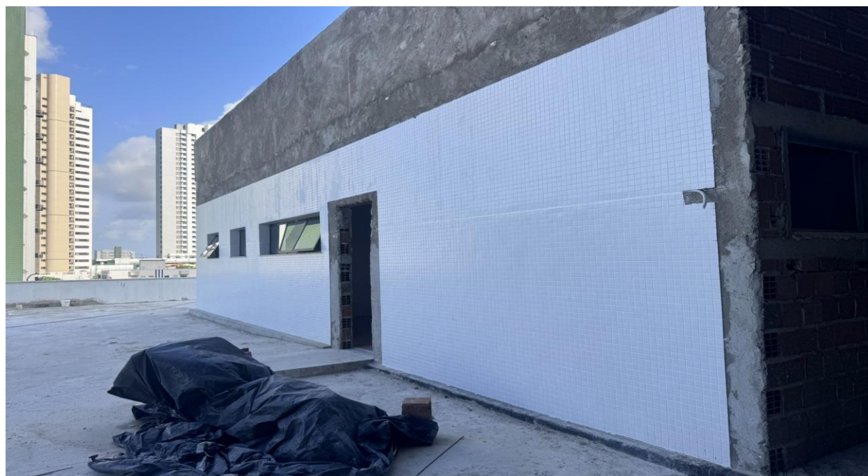
Figura 13. Janelas Maxim Ar instaladas no auditório.
