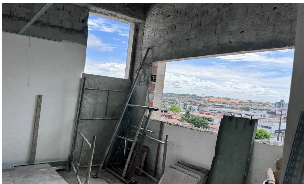
Figura 6, Alvenaria de fechamento de parede na lateral da edificação.
