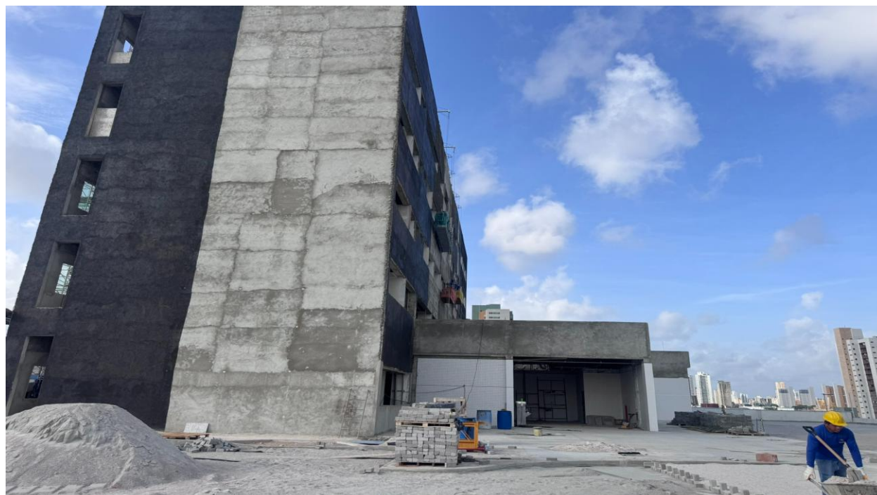
Figura 8. Aplicação de chapisco e emboço de na fachada lateral da edificação.
