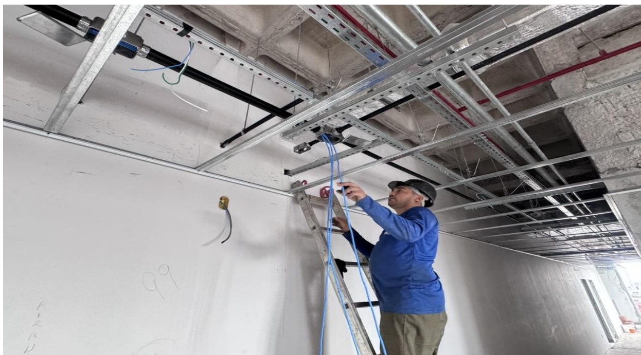
Figura 28. Instalação dos cabos e eletrodutos..
