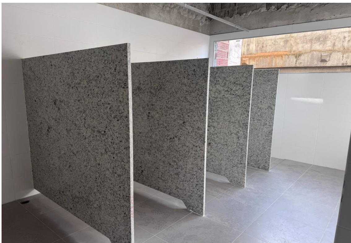
Figura 5. Divisórias instaladas no banheiro coletivo masculino no pavimento semienterrado 2.
