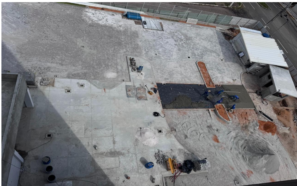
Figura 17. ACABAMENTO MECÂNICO ÁSPERO PARA PISO DE CONCRETO ARMADO..
